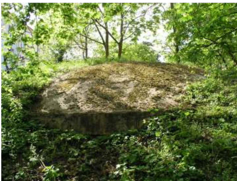
foto. č. 2 Pohľad na akumul. nádrž – pravá, odkrytá časť betónu kopuly
