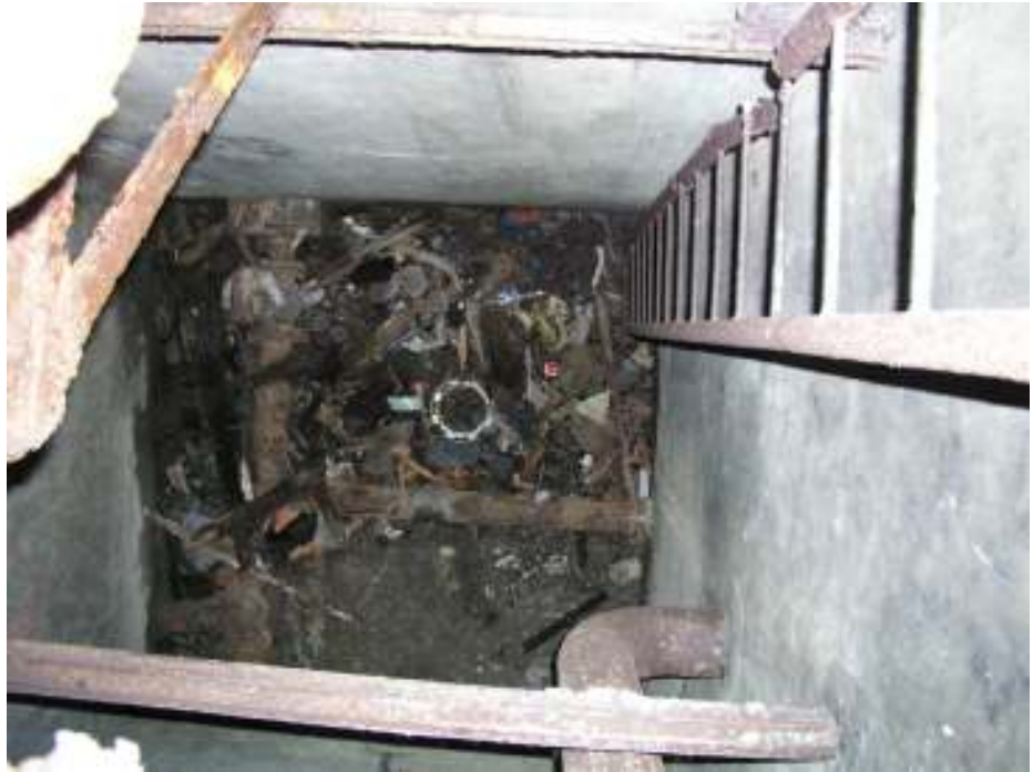
foto. č. 7 Pohľad do podzemnej časti manipulačnej komory
