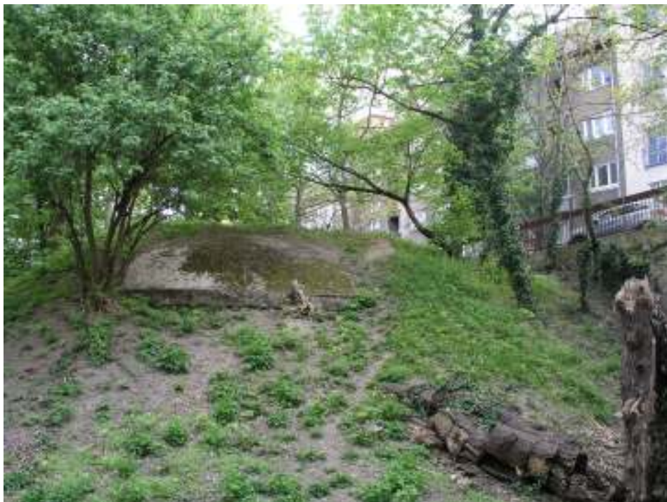
foto. č. 1 Pohľad na akumul. nádrž – ľavá, odkrytá časť betónu kopuly
