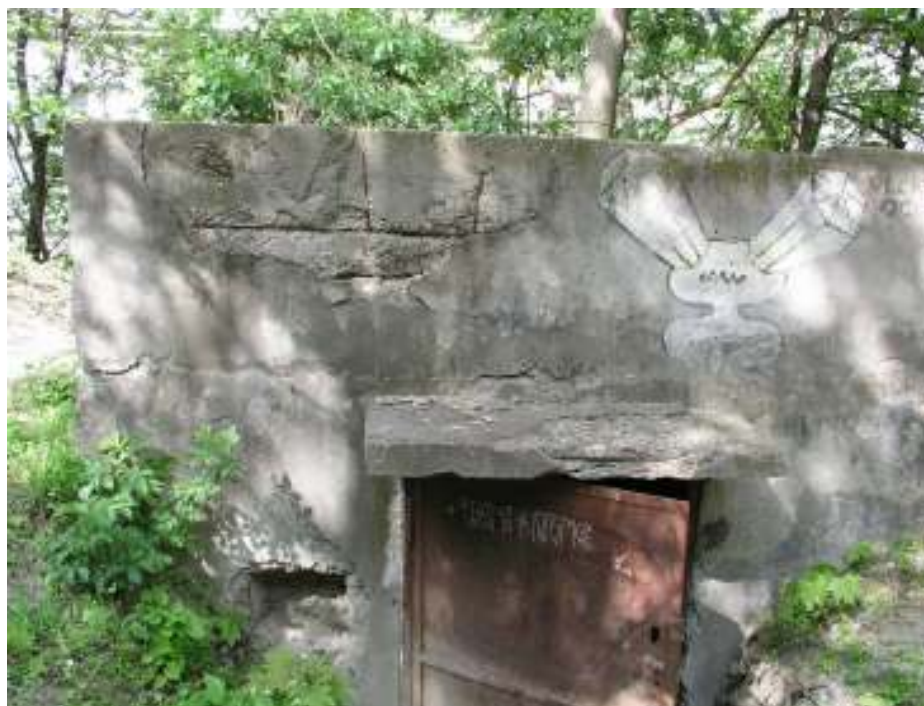
foto. č. 4 Pohľad na manipulačnú komoru, čelný pohľad vstupu
